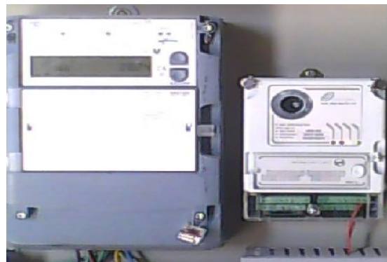
شکل ۵ - نحوه نصب مودم در کنار کنتور
