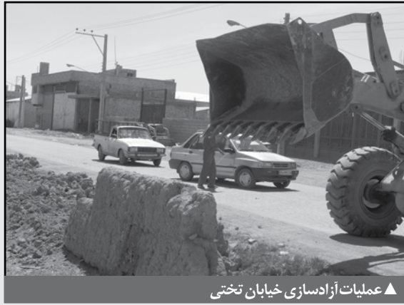
عملیات آزادسازی خیابان تختی
