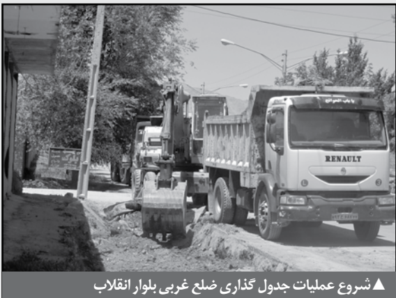
شروع عملیات جدول گذاری ضلع غربی بلوار انقلاب
