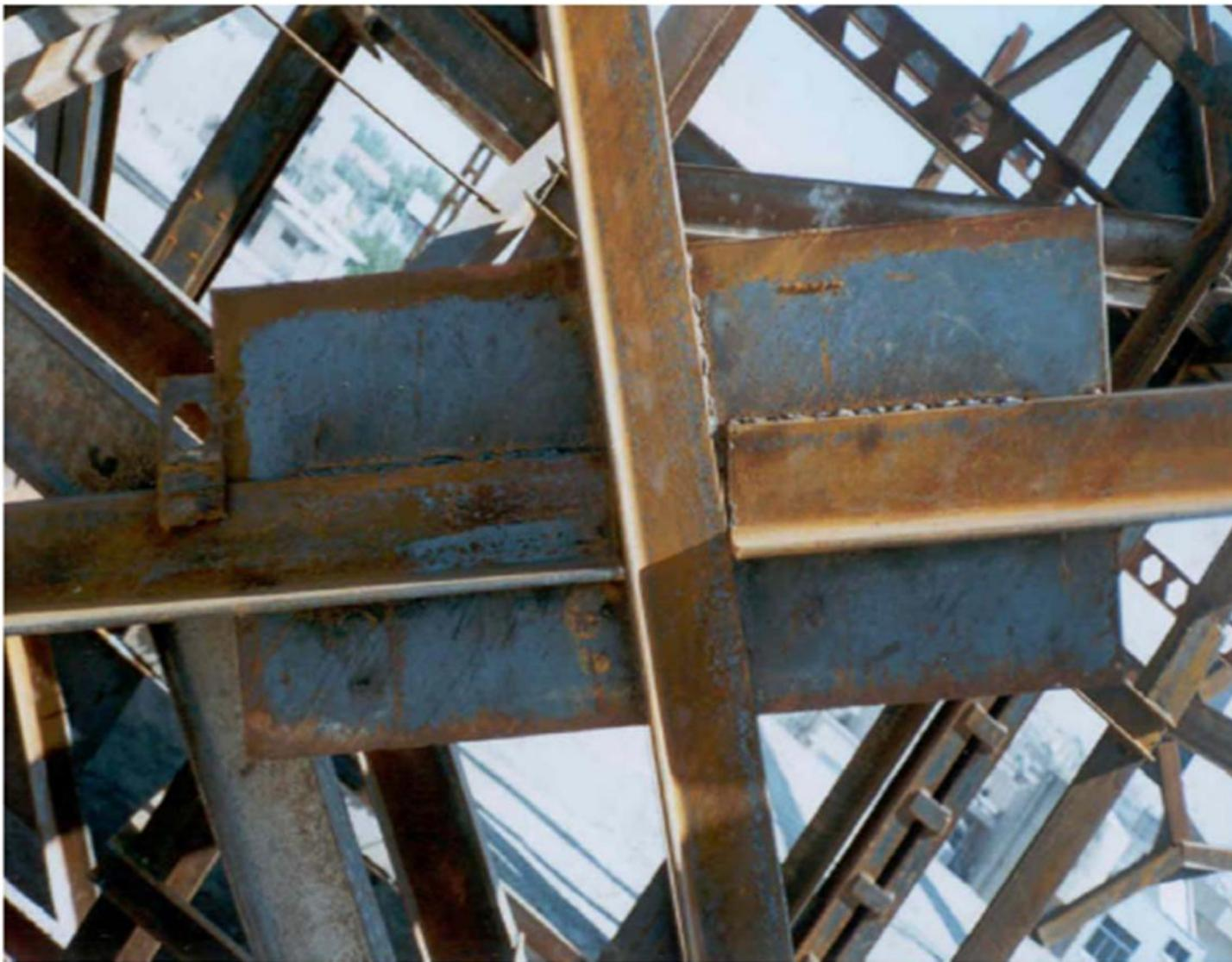
جوش نامناسب در ورقهای اتصال مهاربند
