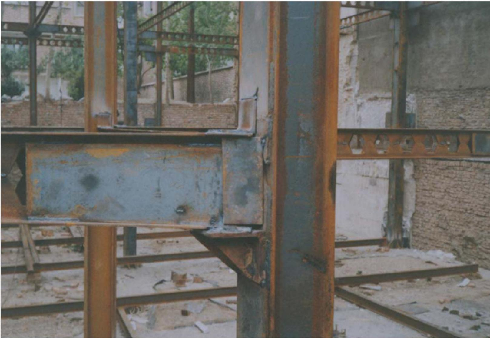
اجرای نادرست قرارگیری تیر روی نشیمن و اتصال نامناسب
