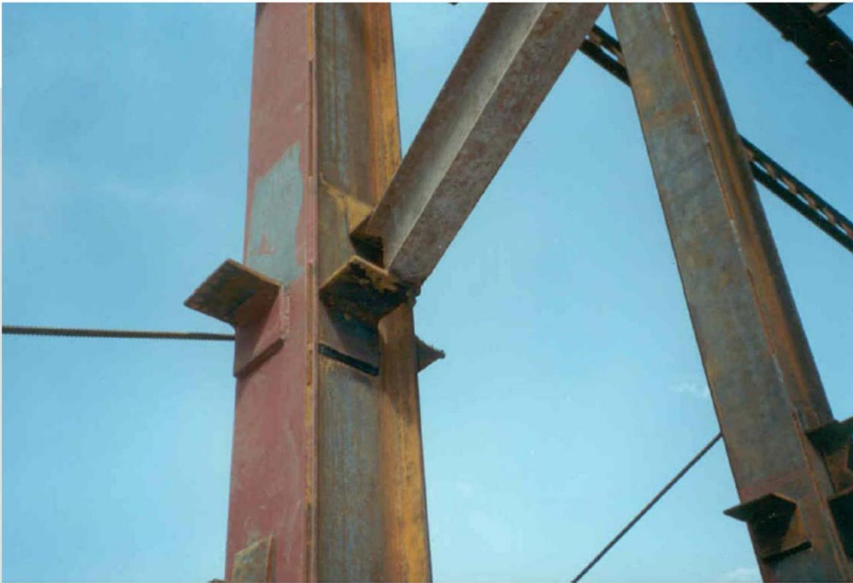
اجرای نادرست قرارگیری تیر روی نشیمن و اتصال نامناسب
