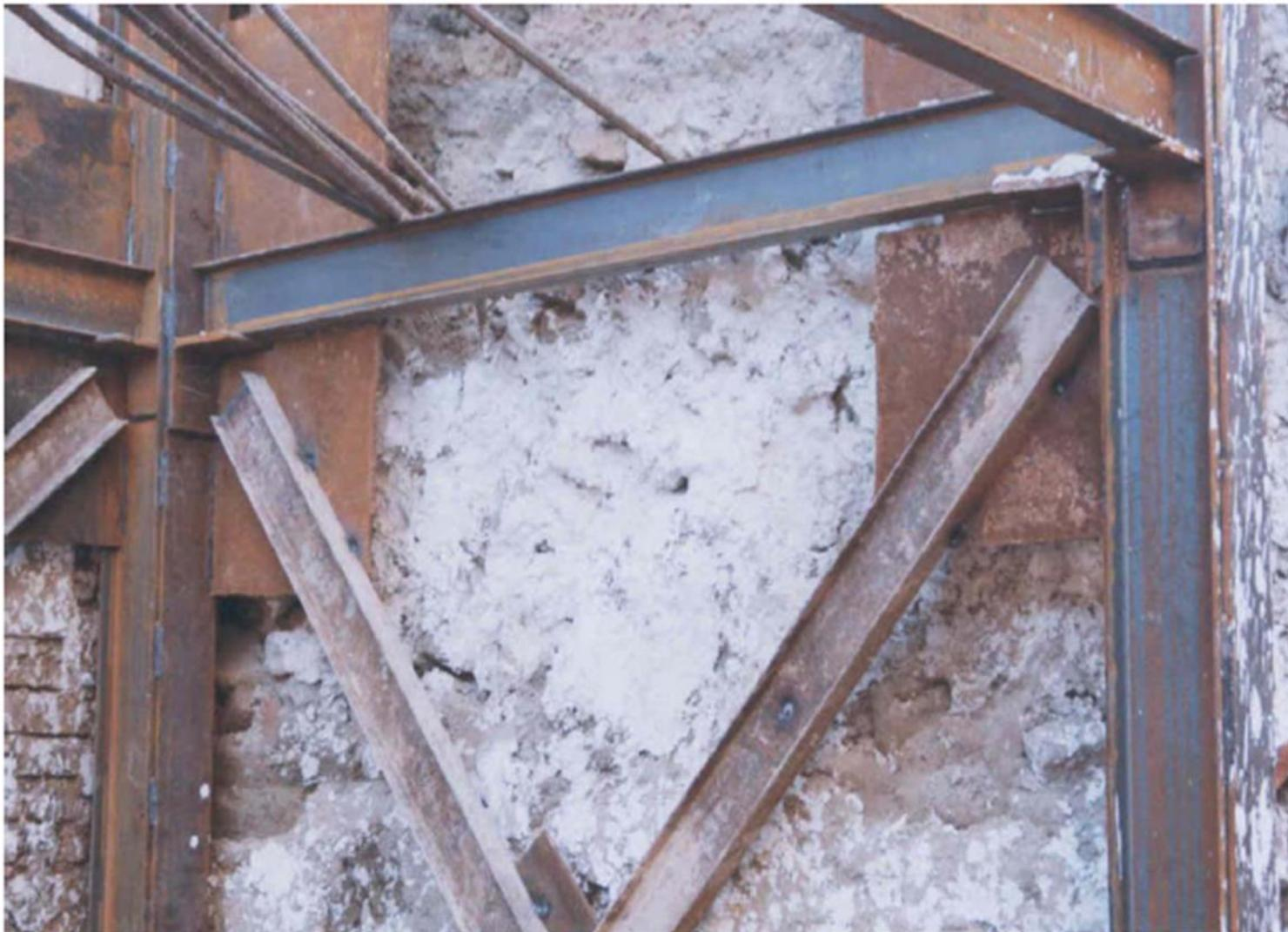
جوش نامناسب در ورقهای اتصال مهاربند
