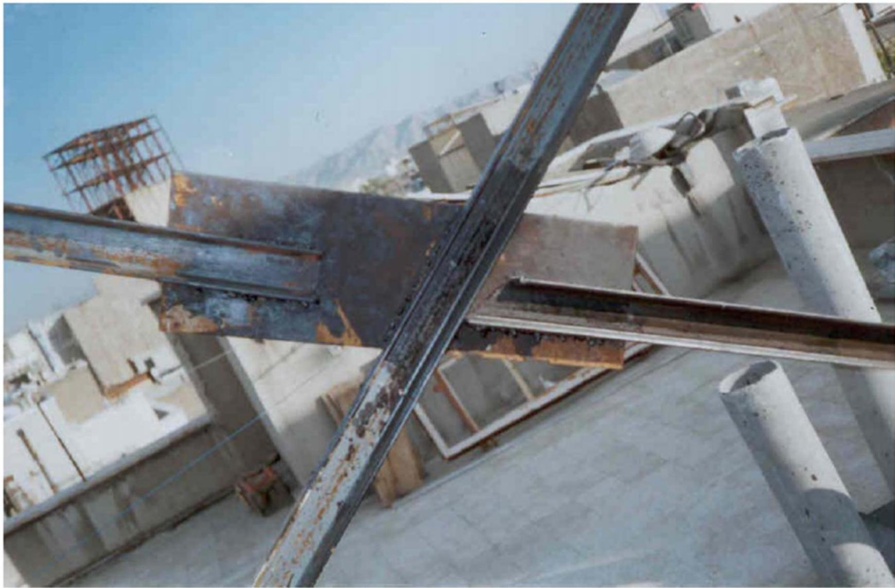
جوش نامناسب در ورقهای اتصال مهاربند واستفاده از پروفیل مستعمل
